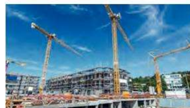
Sites de constructions temporaires
